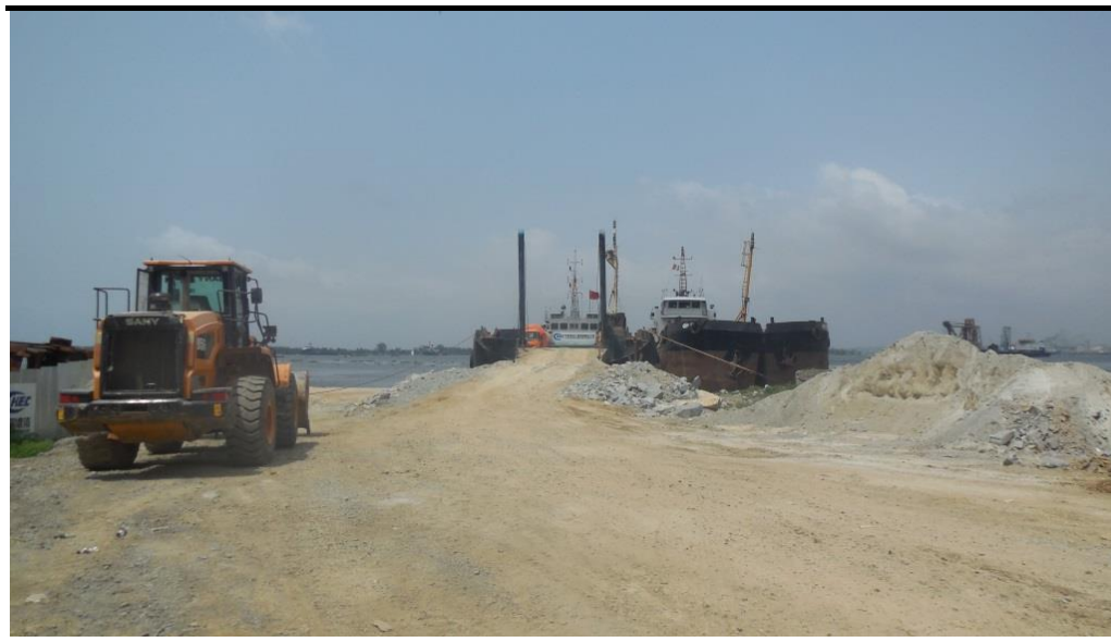
Figure 3.13 Quai de déchargement existant de la CHEC près du site du projet
