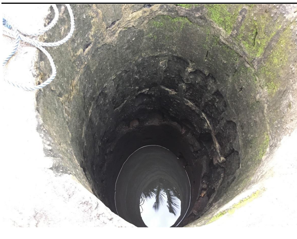
Figure 6.6 Utilisation de l'aquifère superficiel à Avagou Taboth
